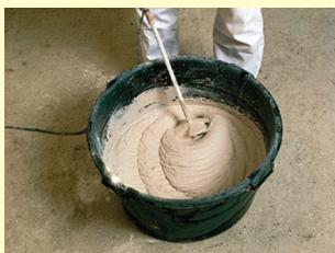
Míchání - Omítka se pomalu a postupně vsype do vody a necháme ji do sebe absorbovat (**1,5 kg suché omítky/1 l vody**). Po cca 5 minutách odležení se rozmíchá do hladka ručně nebo el. míchadlem tak, aby namíchaná směs již neobsahovala žádné suché, nezrozmichané, části.
