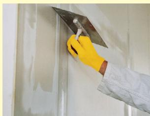
Omítka se nanáší ručně, pomocí zednické lžice a rezového hladítka. Omítka **weber.mur 659** se aplikuje na dostatečně navlhčený nebo napenetovaný podklad v tloušťce 0 – 10 mm.
